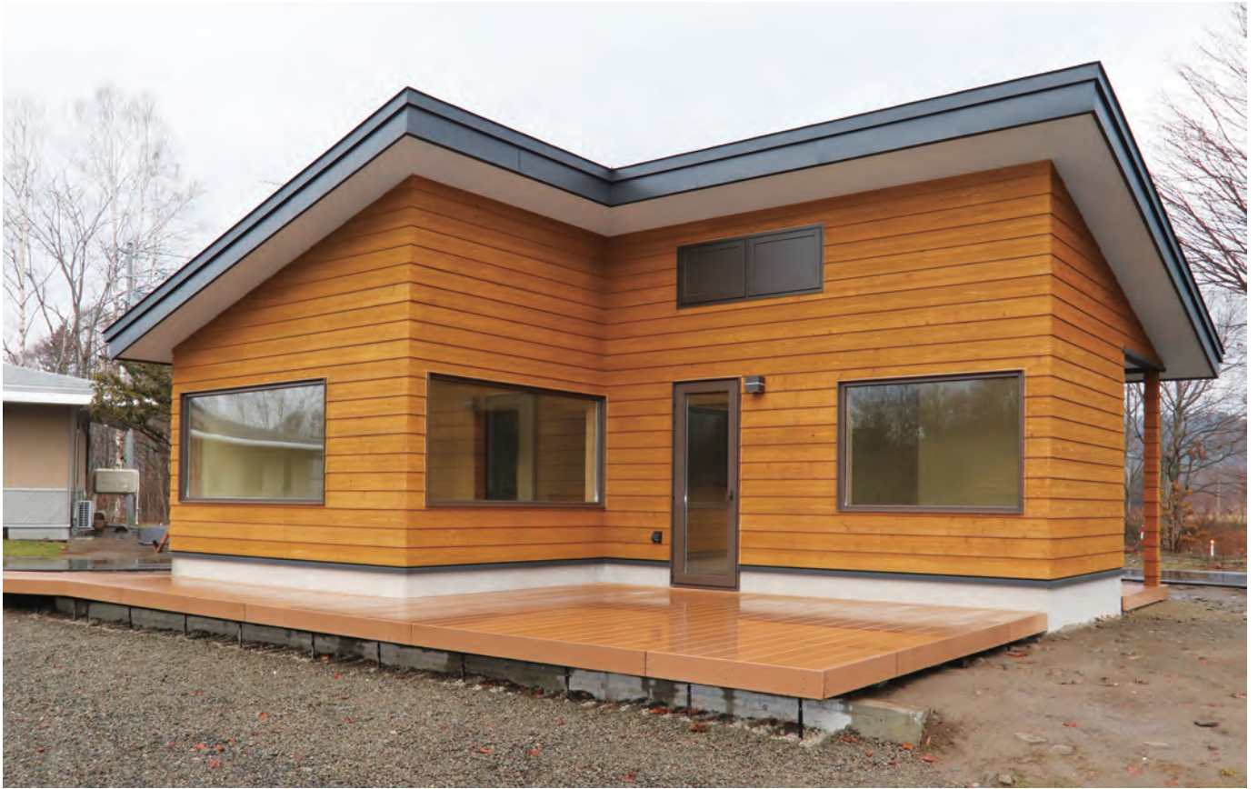
二風谷コタン休憩施設「アリキキ」 施工：有限会社村上組
