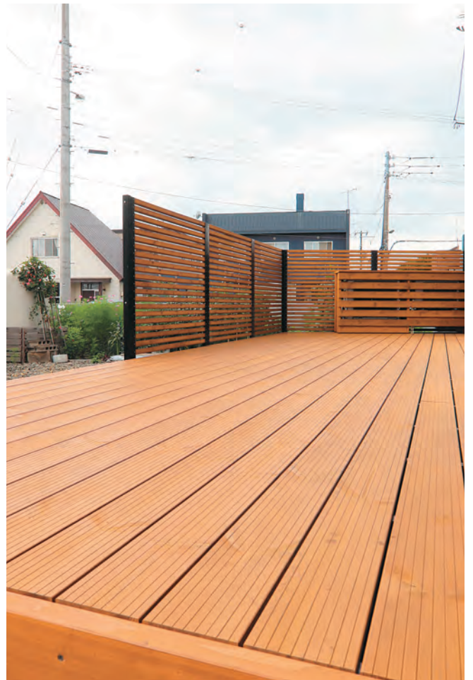
施工：有限会社家基建設
