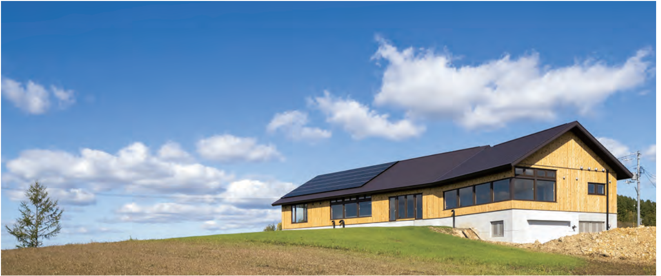
外装材：レッドパイン（サーモウッド）
