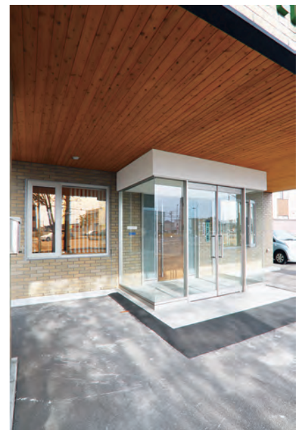
天井 内装材：飢肥杉 [宮崎県産] 設計：伊勢真樹建築設計事務所
