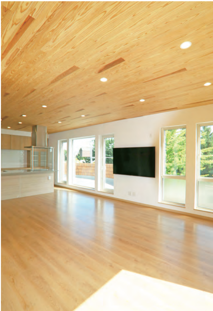
天井 内装材：杉【三重県産】
