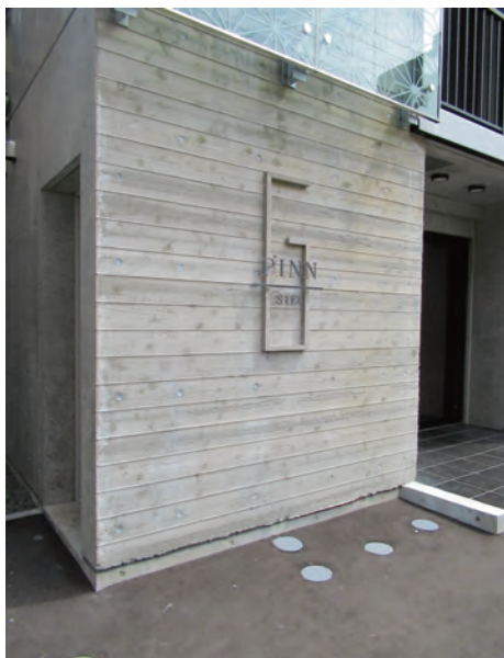
外装材: 飫肥杉 [宮崎県産] PSKR (型枠使用) 施工: 株式会社フォレスト
