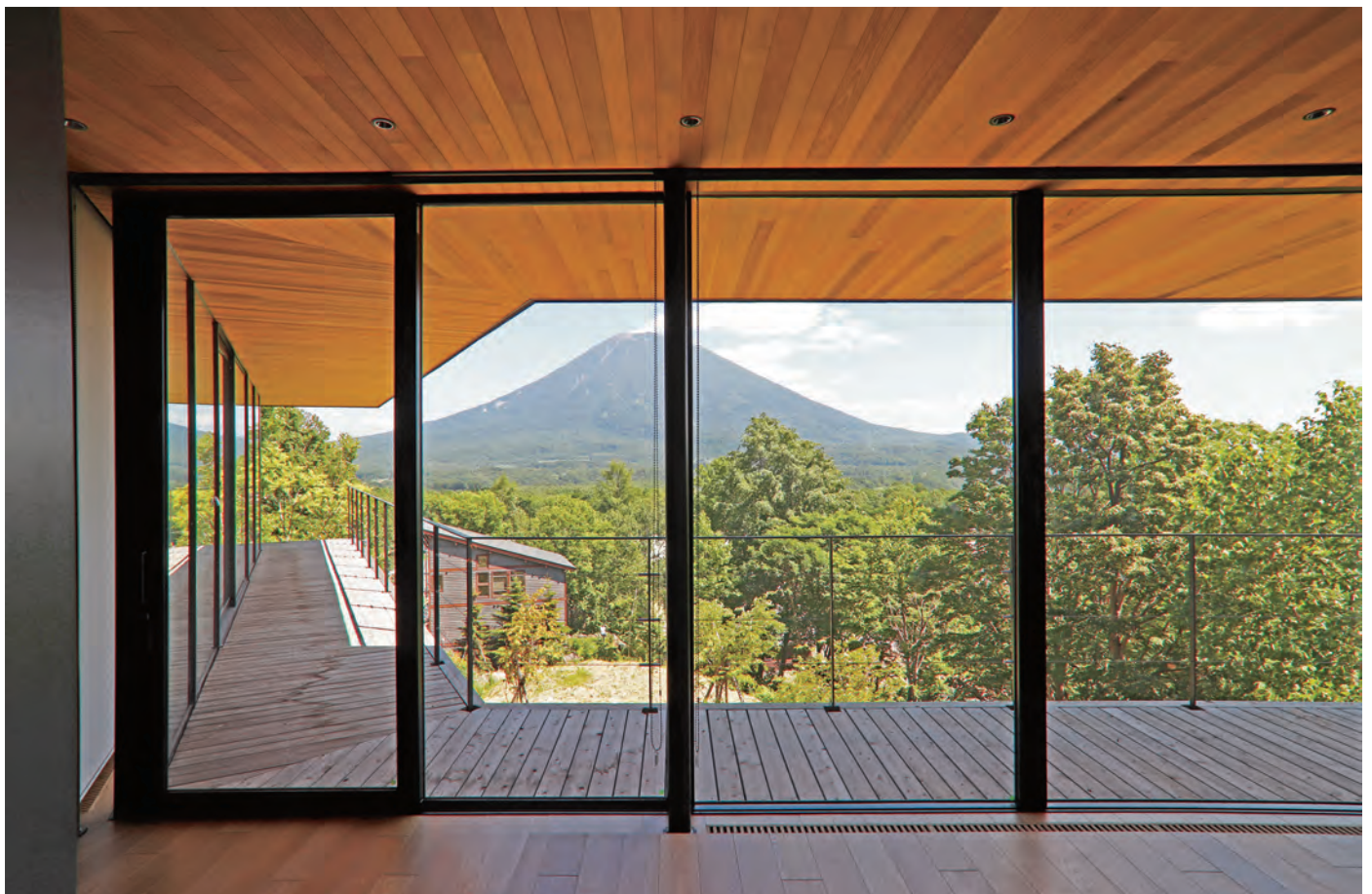
天井 内装材：ウエスタンレッドシーダー
