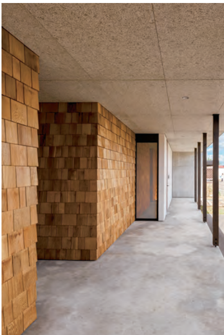
外装材：ウェスタンレッドシーダー 設計：堀部太建築設計事務所 施工：ネオス建築株式会社 撮影：佐々木育弥
