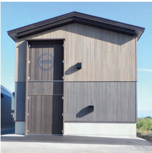
国稀酒造株式会社 第一貯酒庫 設計：平尾建築事務所 施工：巧建工業株式会社
