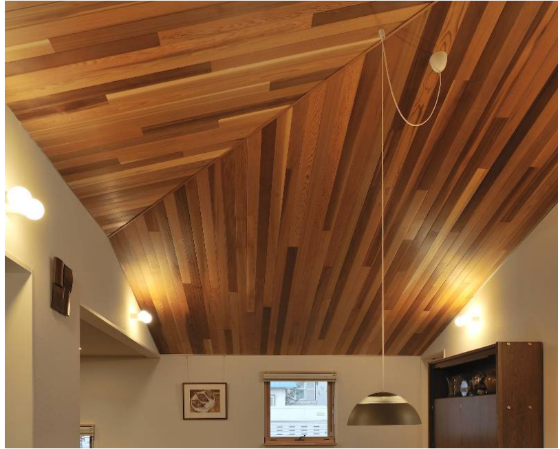
▲乱張り施工例(PRC-8)
